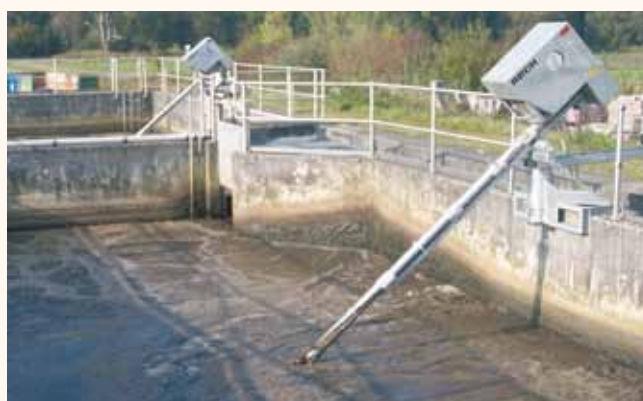
Batidora eléctrica con fijación estacionaria para fosas abiertas (referencia.: ETR-HS)
