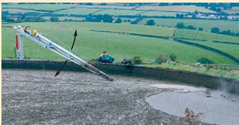
Homogeneización completa en un depósito con 44 m de diámetro
