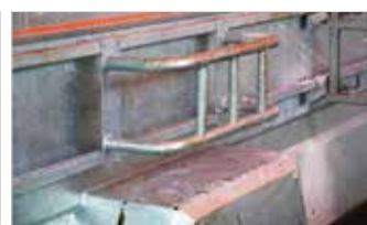
Barras de protección
