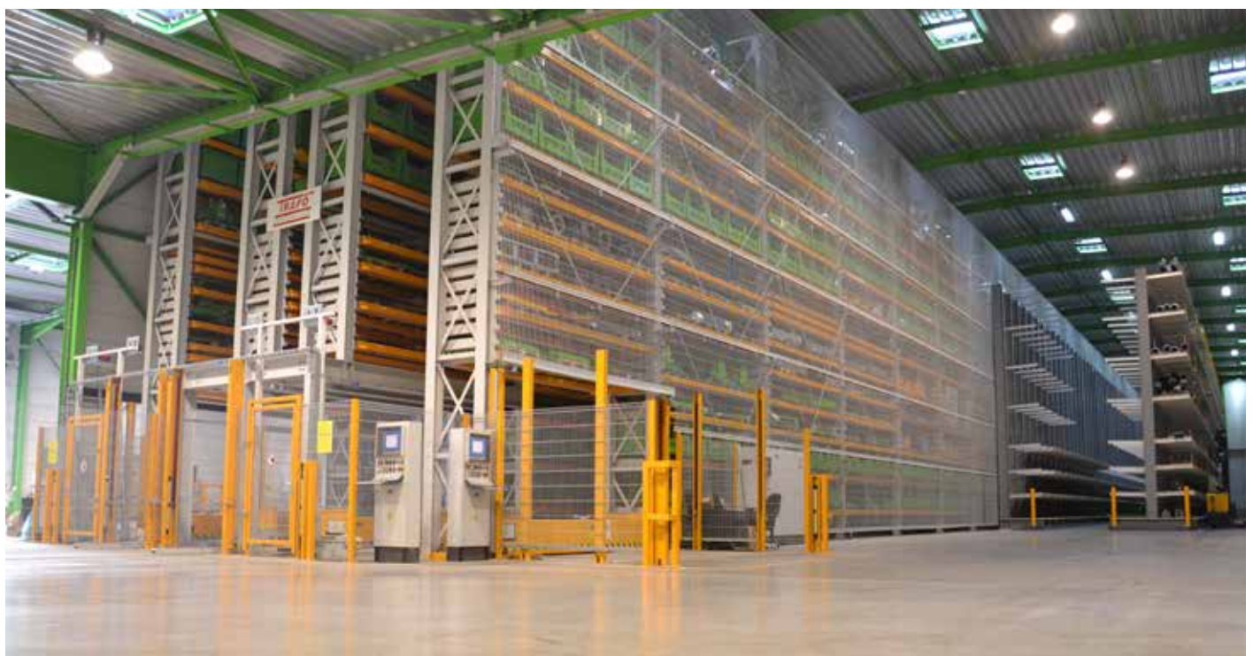
Almacenes automatizados de 28.000 m 3
